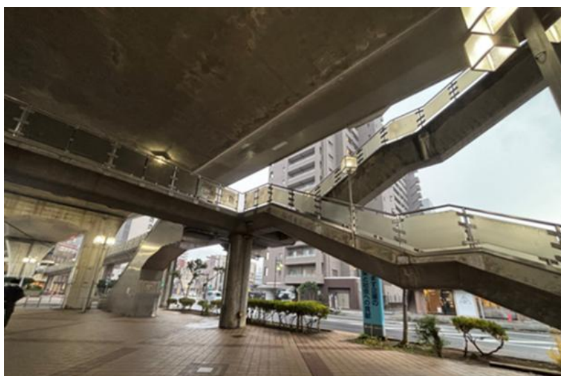
図 4.4-7 土浦駅前通りに残る歩道橋
