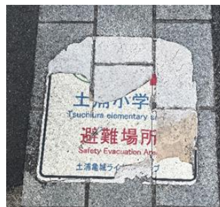
図 1.5-31 歩道上に設置された避難誘導看板
