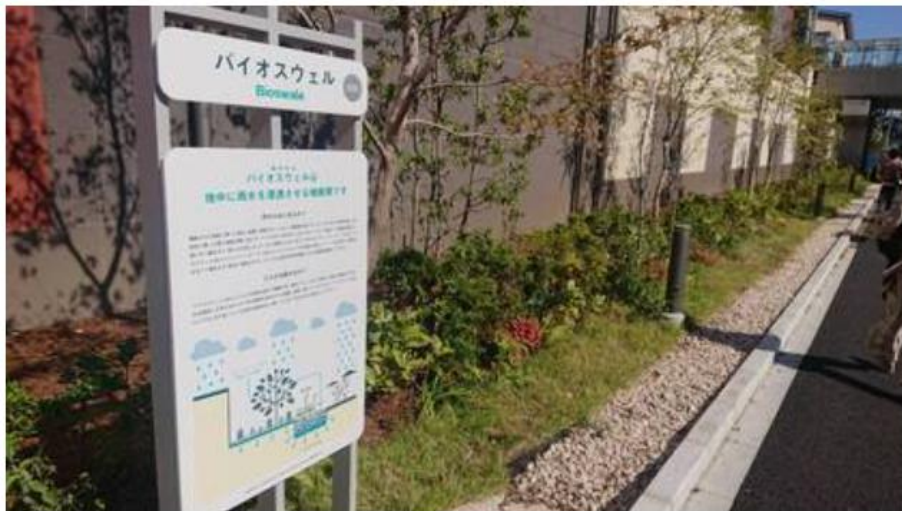
図 4.4.2.2 バイオスウェル設置事例
