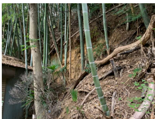
図 1-5.9 崩れかかっている急傾斜地 (2024 年 10 月 25 日発表者撮影：西真鍋にて)
