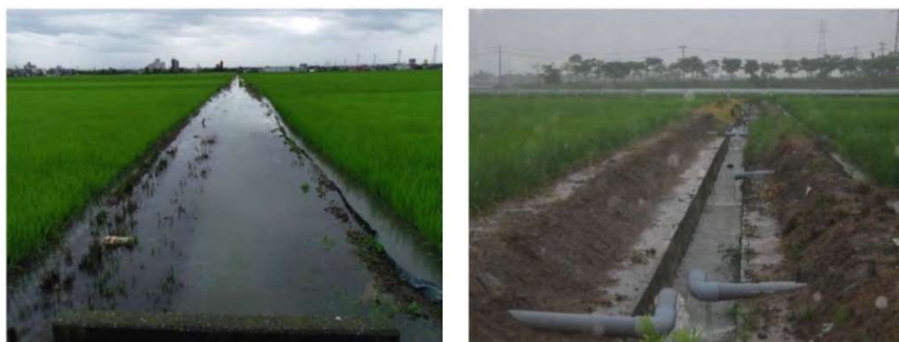
写真2 豪雨時の排水路の状況 左「田んぼダム」未実施 右「田んぼダム」実施 (新潟県 亀田郷土地改良区提供)
