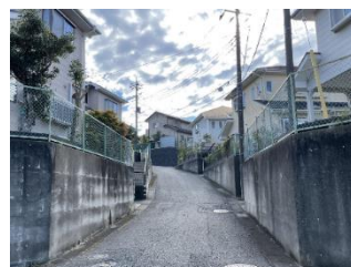
コンクリート壁が立ちはだかる景観
