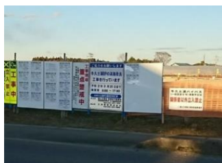
写真 5.5-1 国道六号道路改良工事の着工
