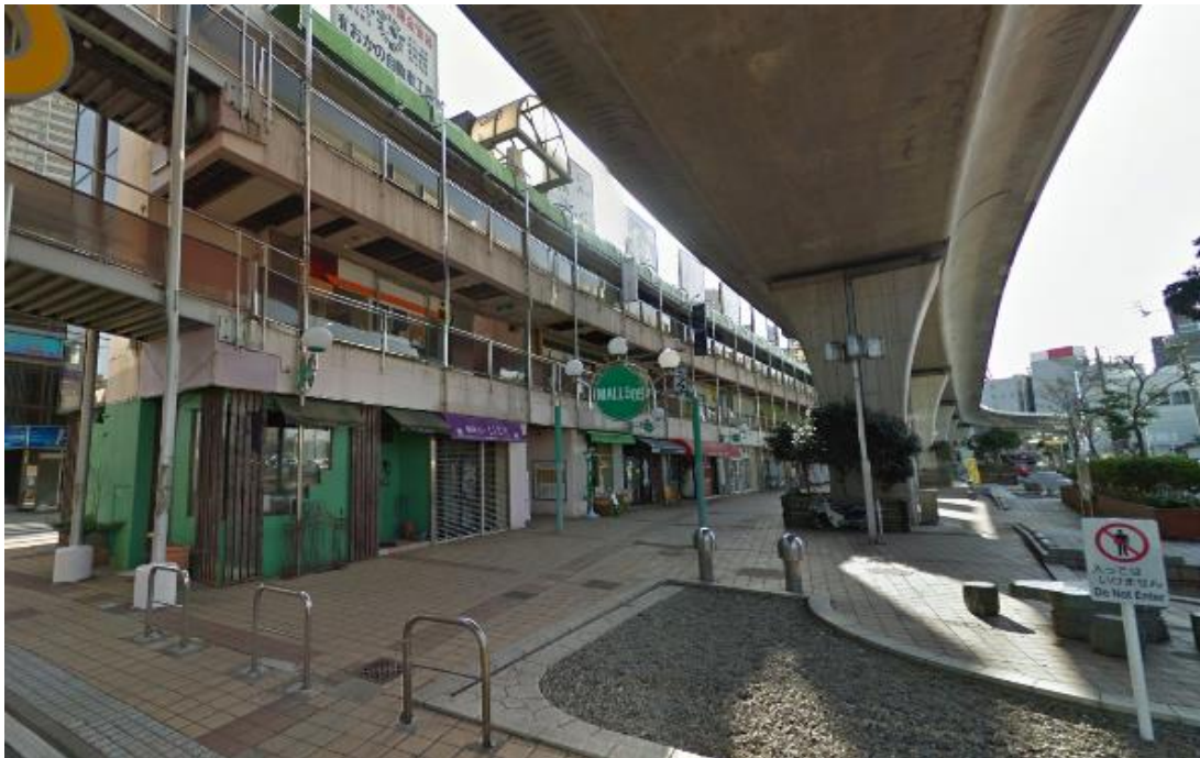
図 3.3-1 モール 505 の現状
