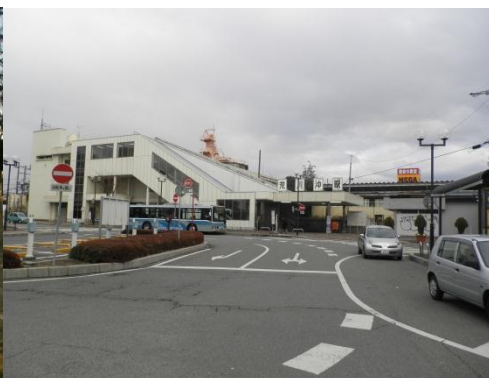
図 36 荒川沖駅付近
