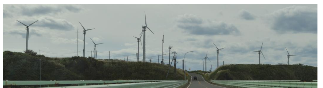
北海道松前町の国道224号線沿いに立ち並ぶ小型風力発電 (2022年10月藤井康平撮影)
